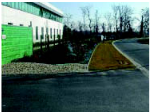
Bordures et accotements végétalisés
