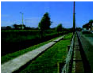
Traitement paysager de voirie avec liaisons douces
